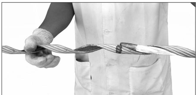
**3.** Prenda as extremidades do cabo com uma camada de fita plástica isolante. Escolha o subconjunto que contém o maior número de varetas e aplique metade dele no cabo condutor, iniciando a aplicação a partir da marca central. Certifique-se de que a direção de encordoamento do cabo e do Preformado é a mesma.
