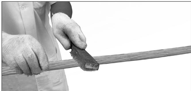
**1.** Com uma escova de aço, limpe toda a extensão do cabo onde será aplicada a Emenda Condutora.
